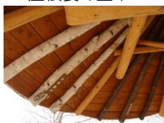
屋根裏の垂木 たるき
